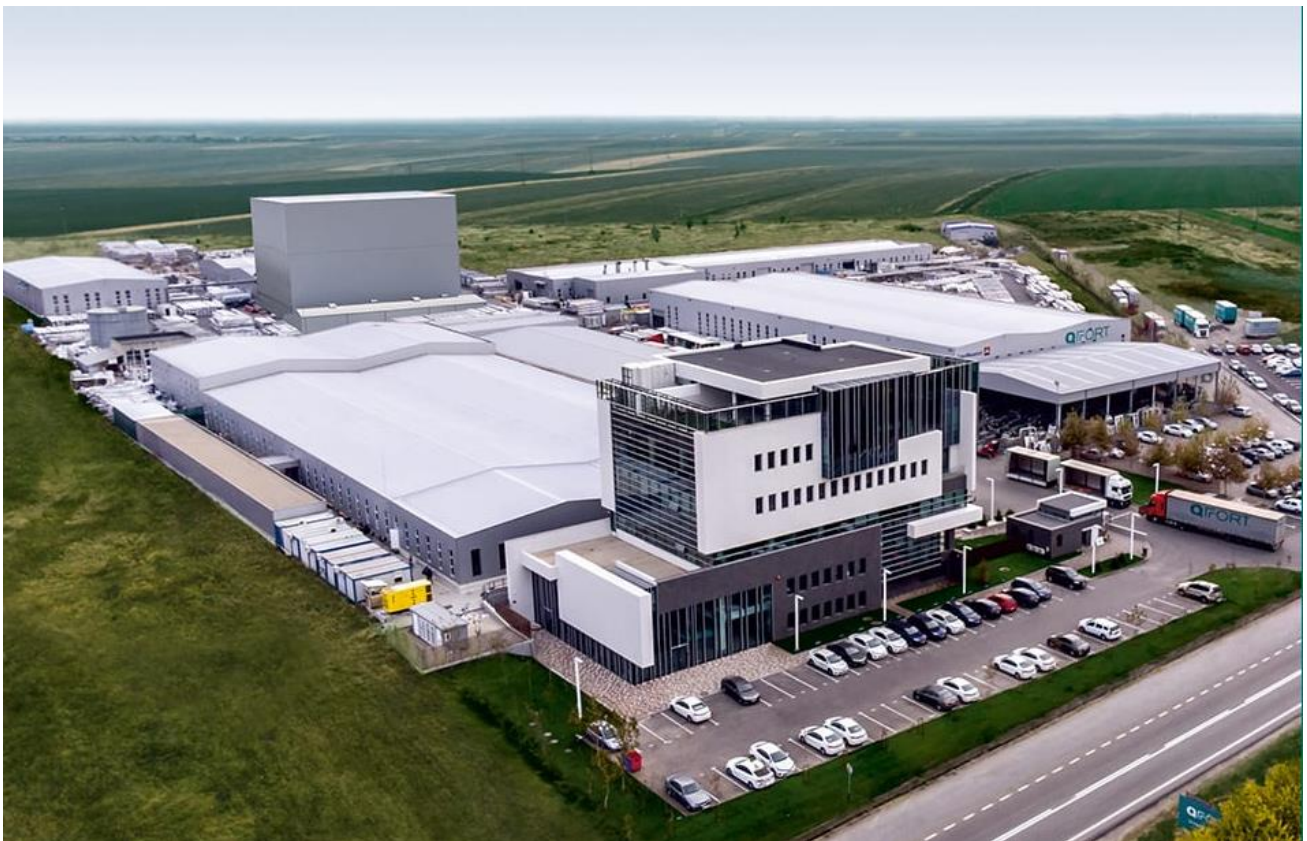
Le site de production de QFORT
